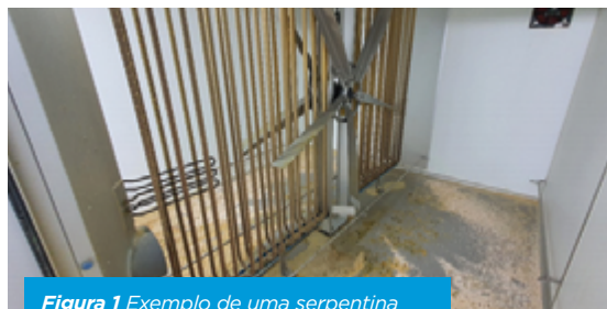
Figura 1 Exemplo de uma serpentina de resfriamento da incubadora coberta com penugens dos pintos.
